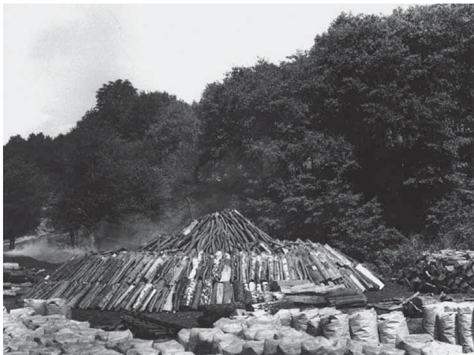
Ryc. 2. Ułożony mielerz przed okryciem oponą – 1978 r. (Archiwum RDLP w Krośnie) Fig. 2. “Mielerz” ready to be covered with a tire – 1978 (Archive of RDSF in Krosno)
