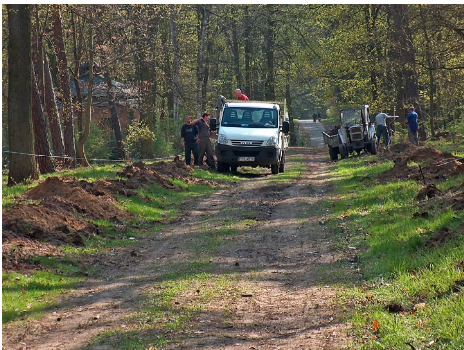
Ryc. 4. Prace przy rekonstrukcji alei świerkowej w oddziale 19 parku-arboretum (fot. B. Olejnik)
