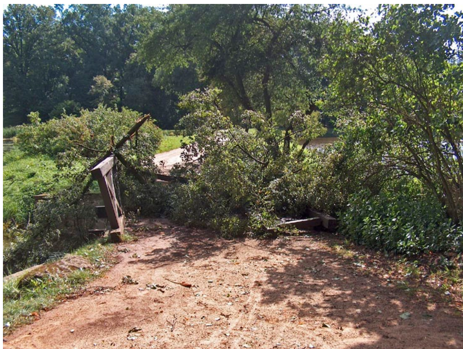
Ryc. 2. Most uszkodzony podczas wichury w parku-arboretum (fot. S. Czołnik)
